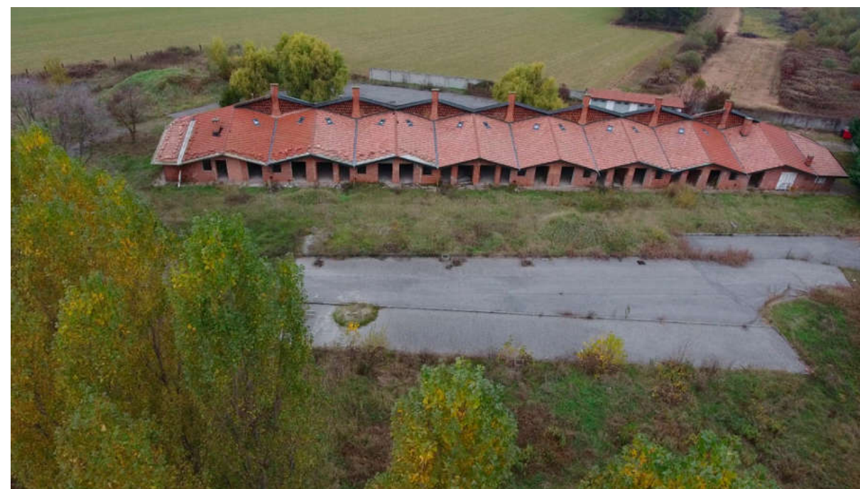
Immagine dello stato di fatto attuale della ex stalla (Rilievo effettuato con drone da attività del PoliTechnico di Torino, corso nel 2018)
