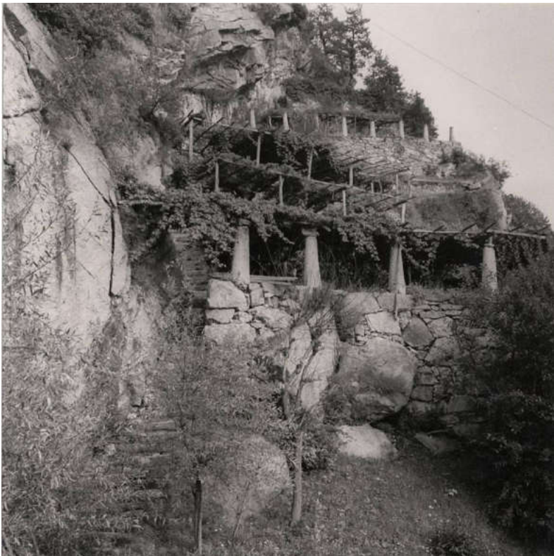
Paesaggio con terrazzamenti e dettaglio di muro a secco che evidenzia modalità costruttive che si adattano all'ambiente, in particolare ai massi erratici e alle pareti di roccia (in alto Montiglie di Settimo Vittone, in basso Carema)
