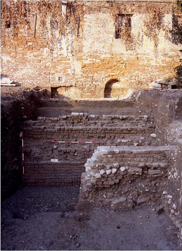
Fig. 9. Muro di fondazione della cinta urbana (foto Chora Cooperativa di ricerca archeologica s.r.l.).
