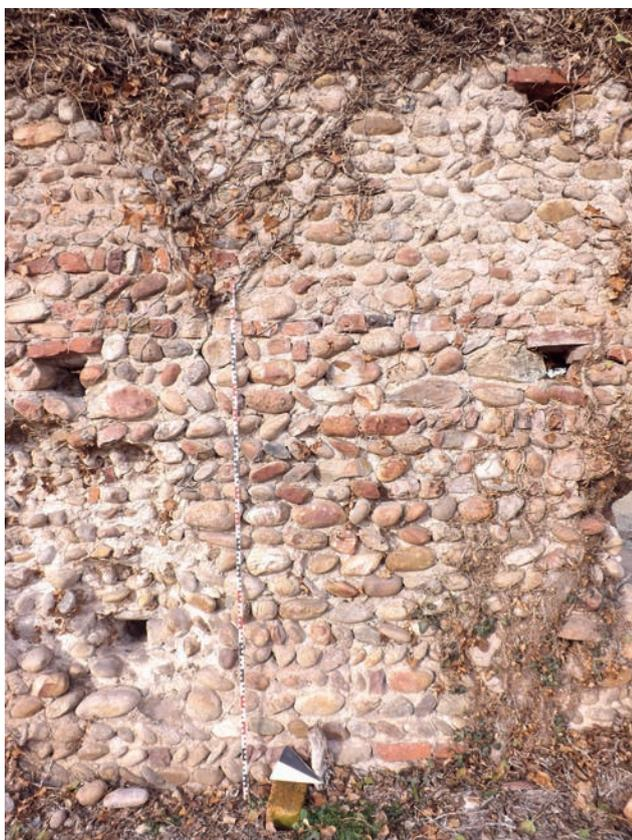
Fig. 50. Cervere. Resti del monastero di S. Teofredo. Particolare della tessitura muraria sul prospetto est (foto F.T. Studio s.r.l.).
