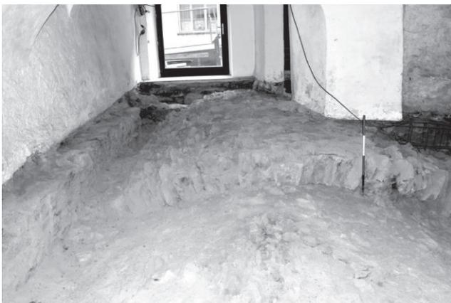
Fig. 32. Salbertrand. Hotel Dieu. Veduta dell'ambiente principale dopo la rimozione della pavimentazione e la messa in luce degli estradossi delle volte, da ovest (foto F. Del Prete).
