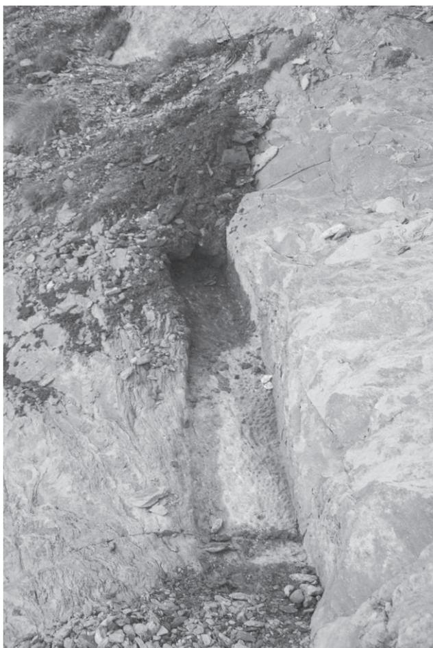
Fig. 9. Balme, Pian della Mussa. Un segmento del canale consumato dall'erosione con alle spalle un tratto ripulito dai detriti. Si nota la finitura a martellina del fondo (foto E. Garoglio).
