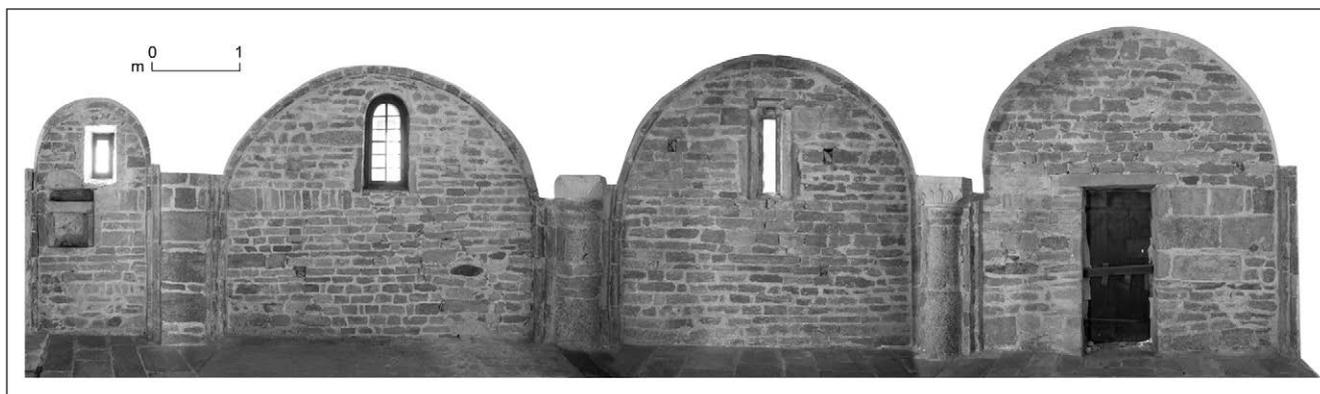
Fig. 10. Fotoraddrizzamento e fotomosaico della parete interna meridionale (E. Casarotti - G. Creti).
